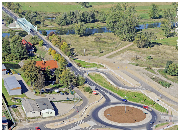
Wybudowana obwodnica Czarnkowa – część drogi wojewódzkiej nr 178, jednej z najczęściej wybieranych przez kierowców tras nad morze. Inwestycja współfinansowana była ze środków WRPO na lata 2007-2013.
